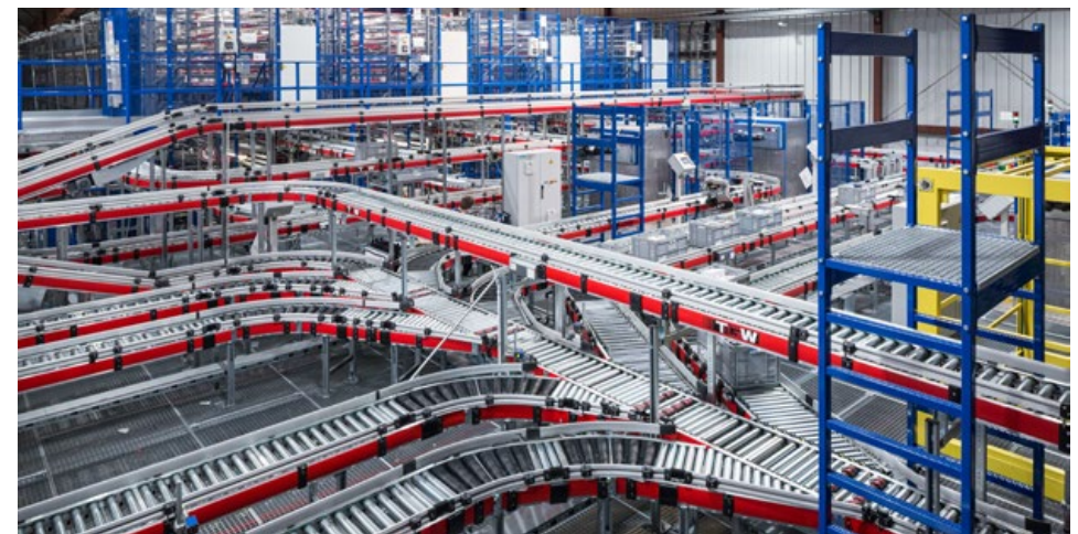
Die automatische Speicher- und Sortieranlage kann stündlich 1.800 Boxen befüllen.
