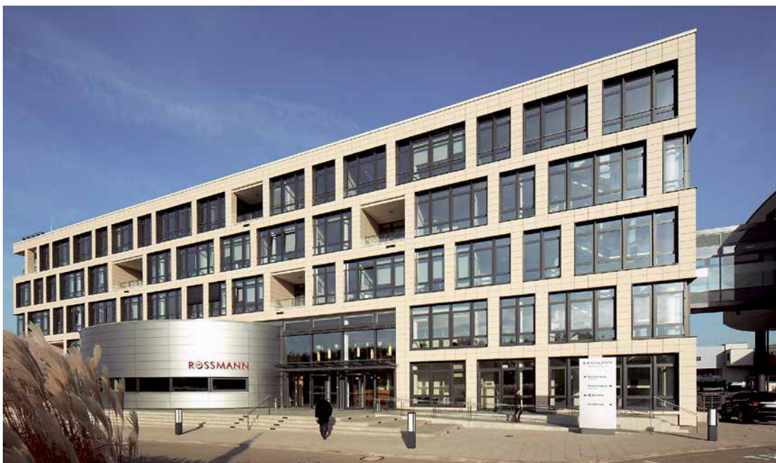
Der Neubau der ROSSMANN-Zentrale in Burgwedel wurde 2011 bezogen.
