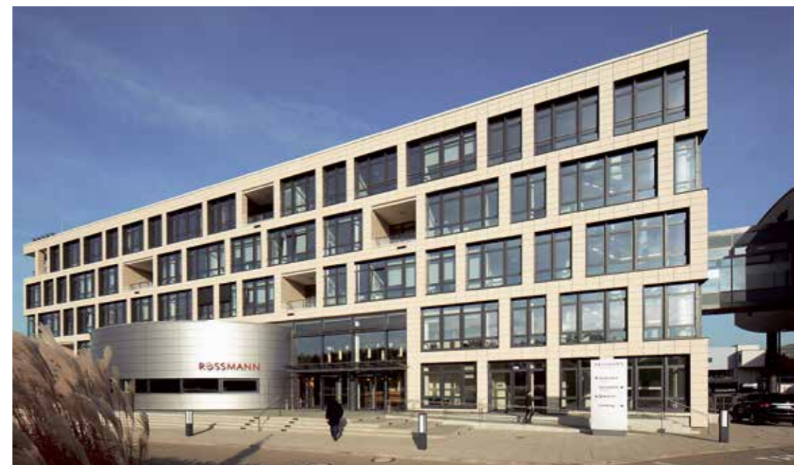
Der Neubau der ROSSMANN-Zentrale in Burgwedel wurde 2011 bezogen.
